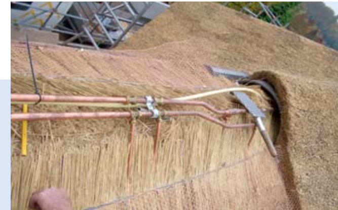
De watertoevoer wordt weggewerkt onder de nokpannen.
